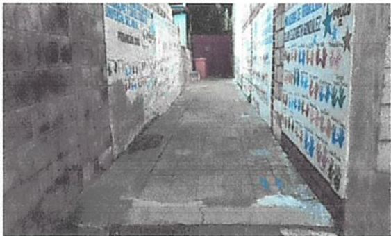
foto 5: reparacion de losa
